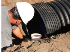
Figura 38 - Aplicação da pasta lubrificante
